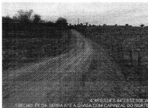
TRECHO PÉ DA SERRA ATE DIVISA DO CAMPINZAL -4.766757, -44.431363
