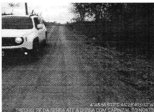
TRECHO PÉ DA SERRA ATE DIVISA DO CAMPINZAL -4.76638, -44.430277
