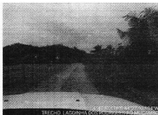
TRECHO LAGOINHA DOS RODRIGUES AO -4.714493, -44.464165
