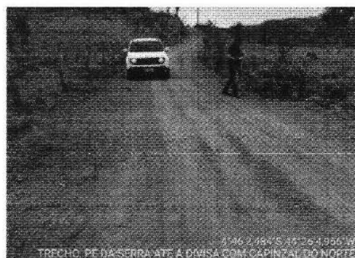
TRECHO PÉ DA SERRA ATE DIVISA DO CAMPINZAL -4.767357, -44.43471
