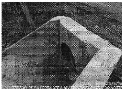
TRECHO PÉ DA SERRA ATE DIVISA DO CAMPINZAL -4.863923, -44.367544
