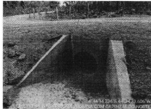
TRECHO PÉ DA SERRA ATE DIVISA DO CAMPINZAL -4.742843, -44.409335
