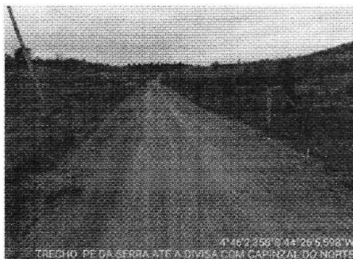
TRECHO PÉ DA SERRA ATE DIVISA DO CAMPINZAL -4.767322, -44.434888
