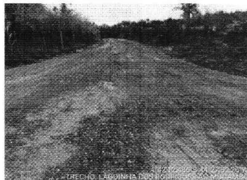
TRECHO LAGOINHA DOS RODRIGUES AO -4.703472, -44.464623
