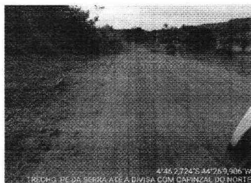
TRECHO PÉ DA SERRA ATE DIVISA DO CAMPINZAL -4.767405, -44.436057
