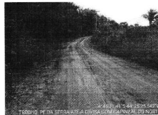
TRECHO PÉ DA SERRA ATE DIVISA DO CAMPINZAL -4.758725, -44.423761
