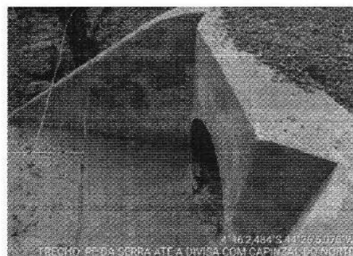
TRECHO PÉ DA SERRA ATE DIVISA DO CAMPINZAL -4.767357, -44.434743
