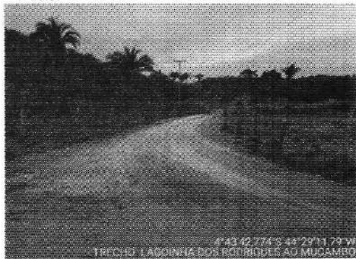
TRECHO LAGOINHA DOS RODRIGUES AO -4.728548, -44.48662
