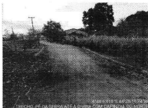
TRECHO PÉ DA SERRA ATE DIVISA DO CAMPINZAL -4.768588, -44.438817
