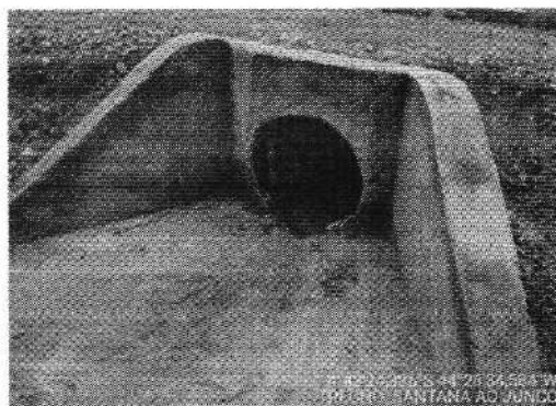
TRECHO SANTANA AO JUNCO -4.80676, -44.476273
