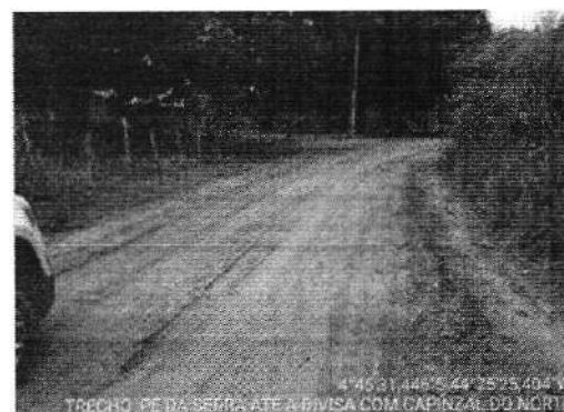
TRECHO PÉ DA SERRA ATE DIVISA DO CAMPINZAL -4.758736, -44.423723
