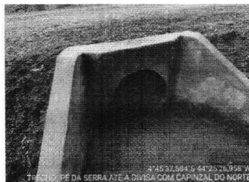
TRECHO PÉ DA SERRA ATE DIVISA DO CAMPINZAL -4.760428, -44.424155
