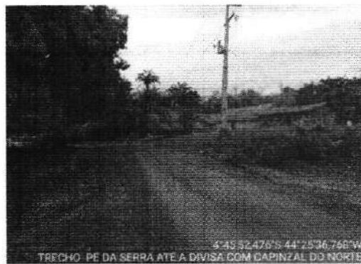
TRECHO PÉ DA SERRA ATE DIVISA DO CAMPINZAL -4.764586, -44.426882
