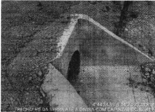
TRECHO PÉ DA SERRA ATE DIVISA DO CAMPINZAL -4.743025, -44.409287
