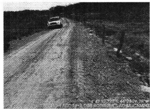
TRECHO LAGOINHA DOS RODRIGUES AO -4.714628, -44.473943
