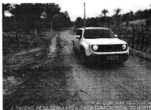
TRECHO PÉ DA SERRA ATE DIVISA DO CAMPINZAL -4.760516, -44.424203
