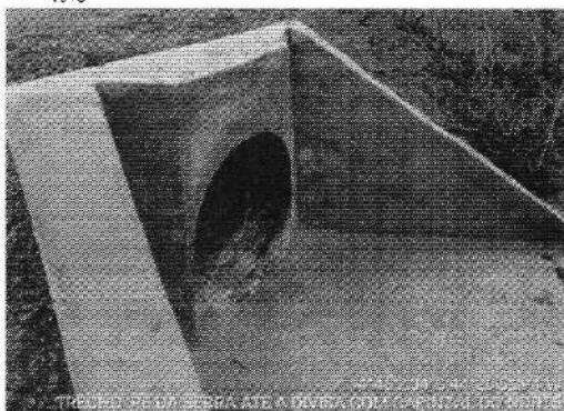
TRECHO PÉ DA SERRA ATE DIVISA DO CAMPINZAL -4.76722, -44.434868
