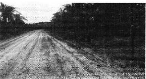
TRECHO PÉ DA SERRA ATE DIVISA DO CAMPINZAL -4.744968, -44.404385
