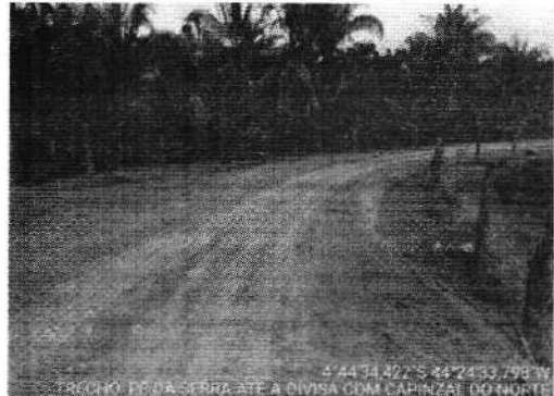
TRECHO PÉ DA SERRA ATE DIVISA DO CAMPINZAL -4.742895, -44.409388
