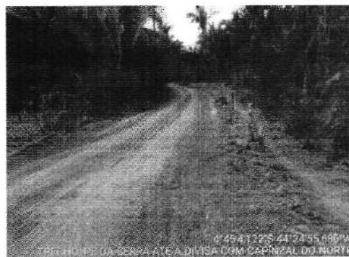
TRECHO PÉ DA SERRA ATE DIVISA DO CAMPINZAL -4.751145, -44.415468
