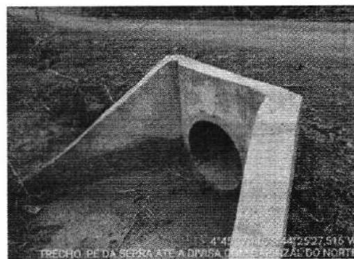
TRECHO PÉ DA SERRA ATE DIVISA DO CAMPINZAL -4.760313, -44.42432
