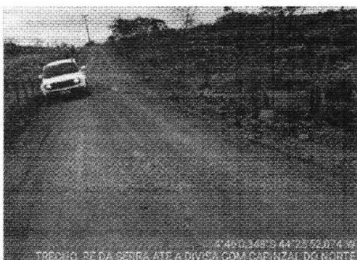
TRECHO PÉ DA SERRA ATE DIVISA DO CAMPINZAL -4.766763, -44.431132
