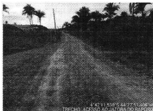
TRECHO ACESSO AO JATOBÁ DO RAPOSO -4.703208, -44.46428
