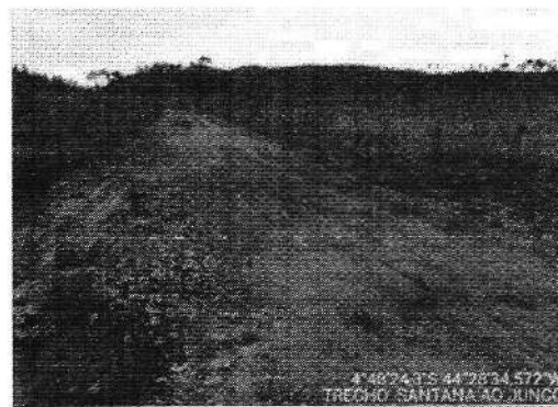
TRECHO SANTANA AO JUNCO -4.80675, -44.47627
