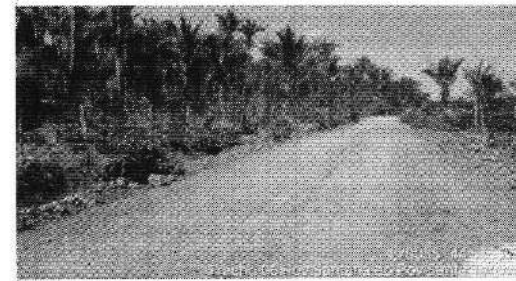
TRECHO Lagoa Velha a Santa Teresa (Comentários, coordenadas, etc.)
