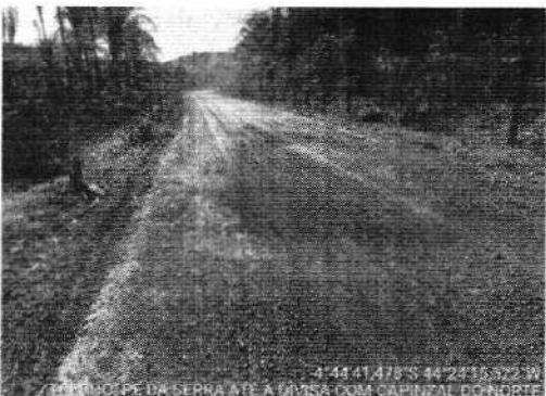
TRECHO PÉ DA SERRA ATE DIVISA DO CAMPINZAL -4.744843, -44.404312
