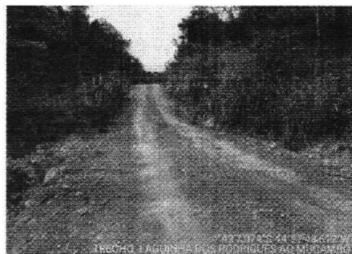
TRECHO LAGOINHA DOS RODRIGUES AO -4.718633, -44.463501
